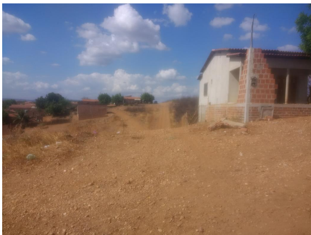
Imagem 10 – Visão geral do fim do trecho.
