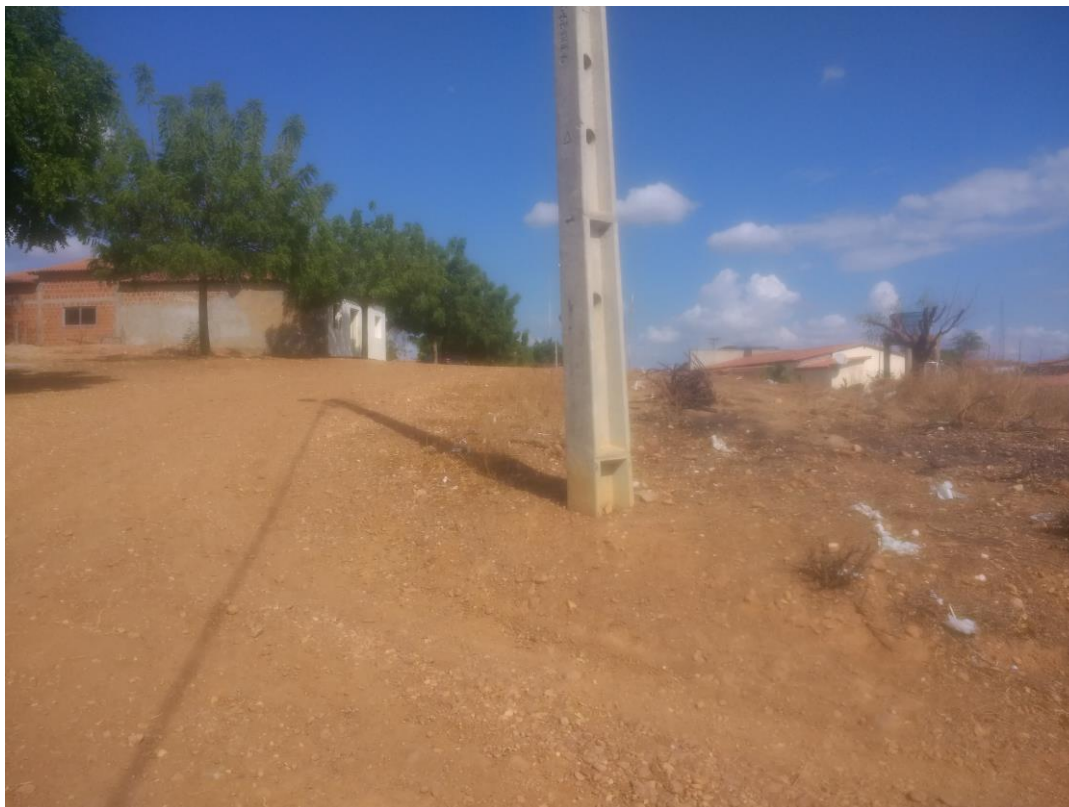
Imagem 08 – Visão geral do fim do trecho.
