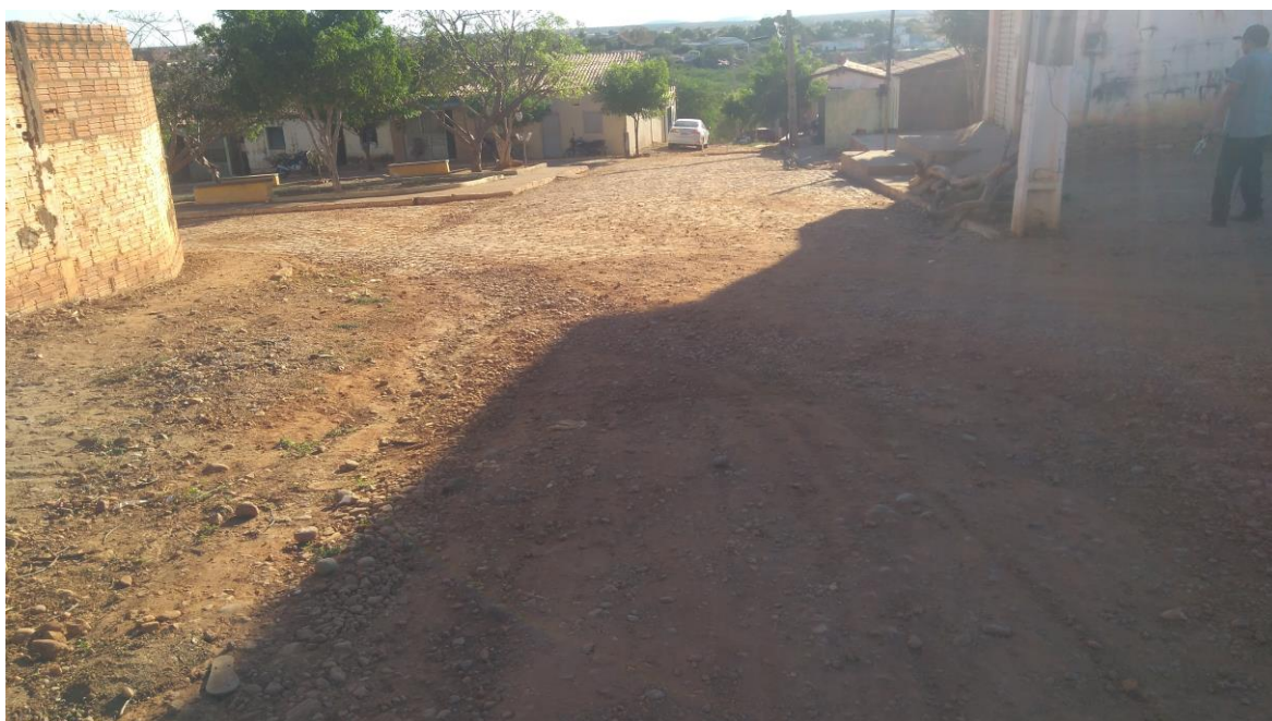
Imagem 06 – Visão geral do fim do trecho.
