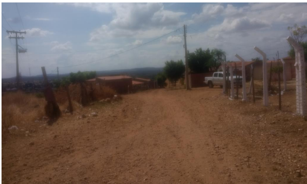
Imagem 11 – Visão geral do início do trecho.
