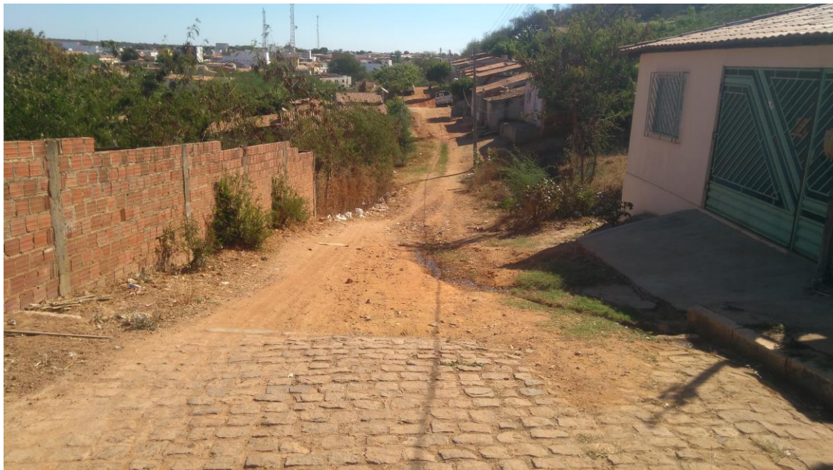
Imagem 01 – Visão geral do início do trecho - Estaca E0.
