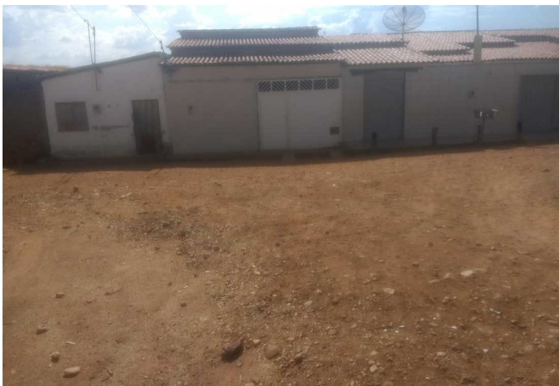
Imagem 19 – Visão geral do fim do trecho.
