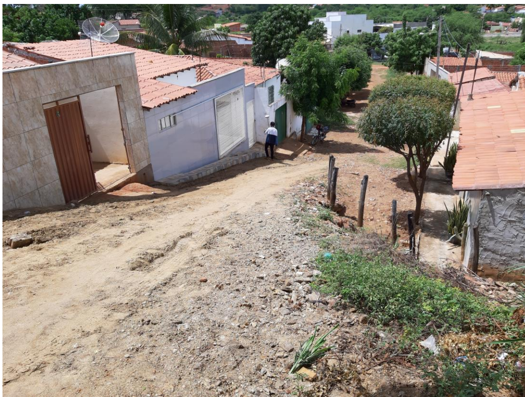
Imagem 14 – Visão geral do início do trecho.
