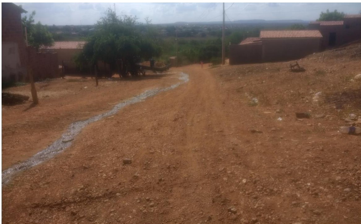
Imagem 13 – Visão geral do início do trecho.
