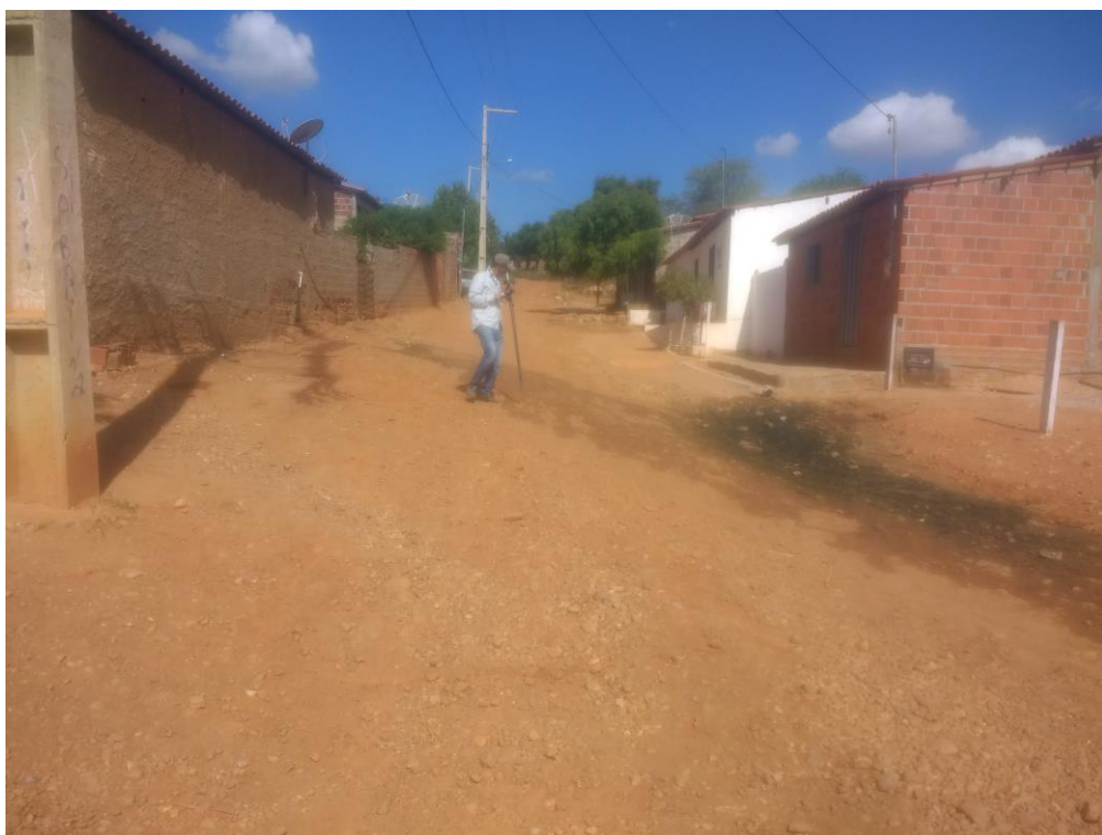
Imagem 12 – Visão geral do fim do trecho.
