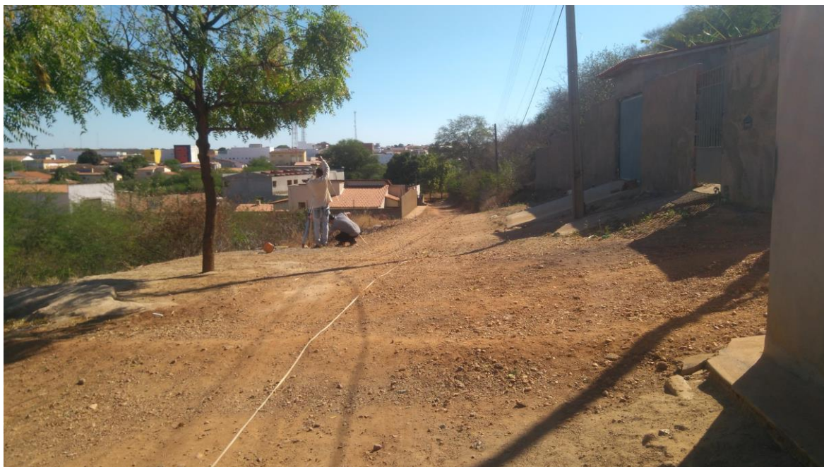
Imagem 02 – Visão geral do trecho a ser pavimentado.
