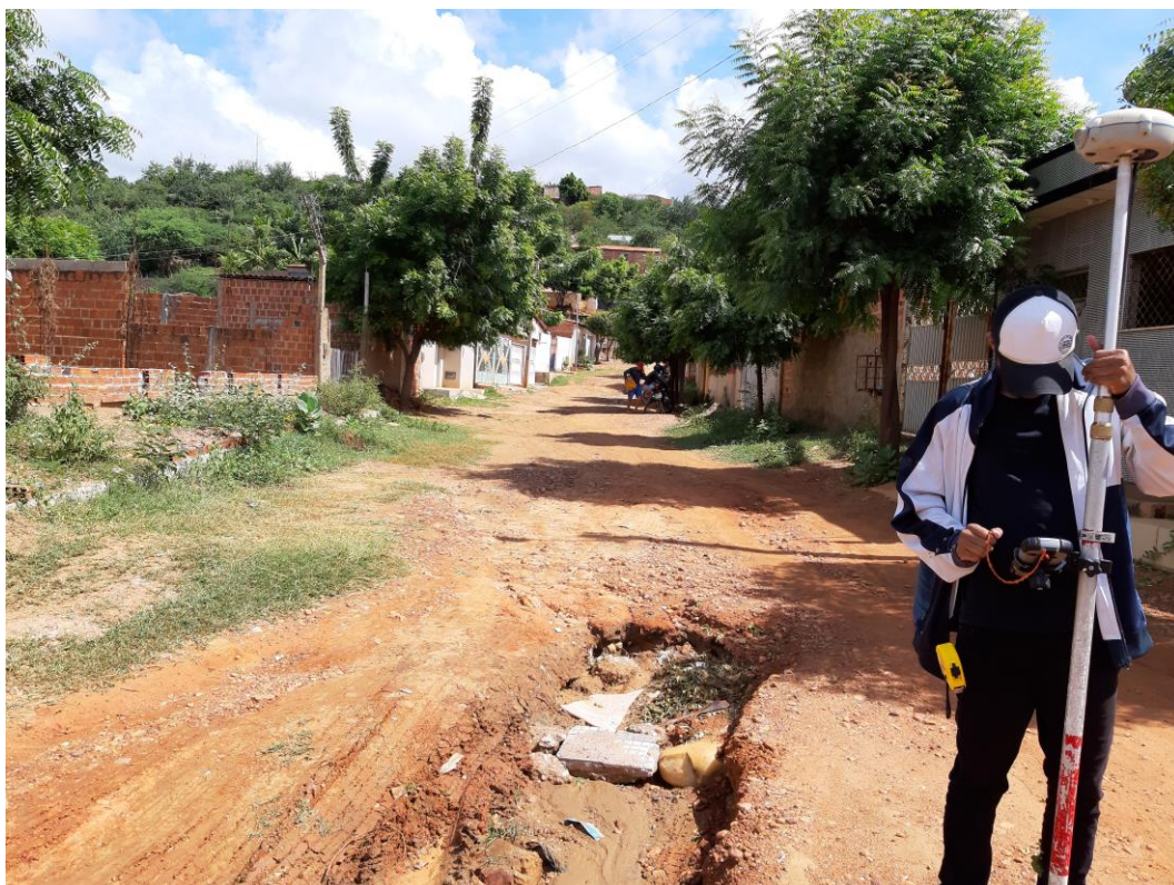
Imagem 15 – Visão geral do fim do trecho.
