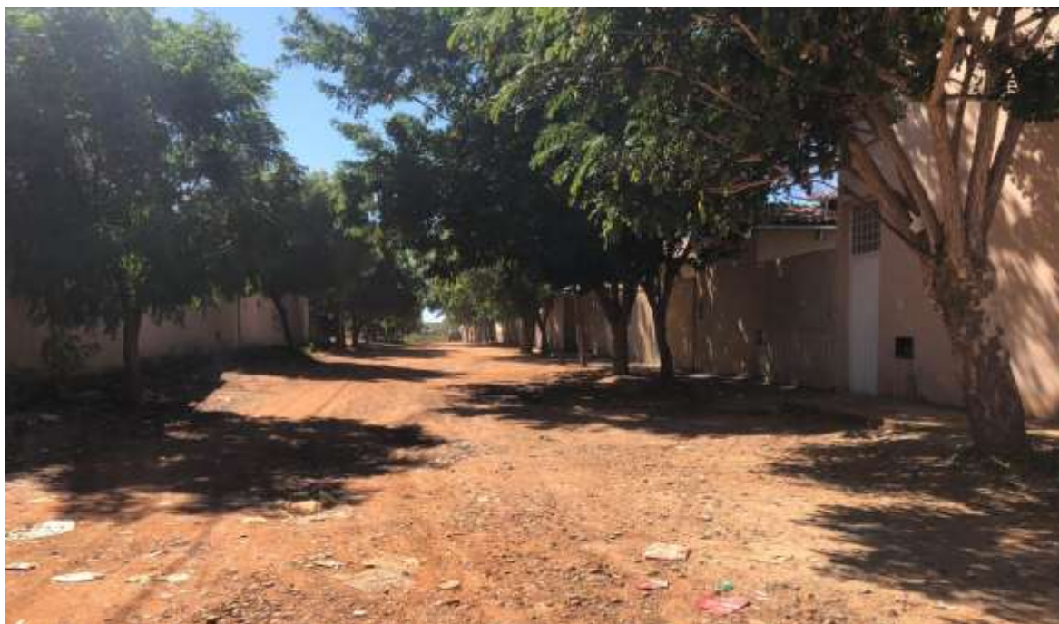
Imagem 04 – Visão geral do fim do trecho.
