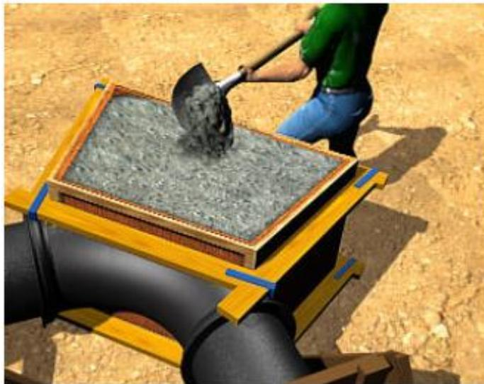
Por fim, será executada a concretagem do conjunto, tomando-se o cuidado para que as juntas do tubo, conexão ou aparelho se mantenham visíveis, possibilitando a verificação da estanqueidade do sistema, quando da realização dos ensaios convencionais, e a posterior manutenção da rede.
