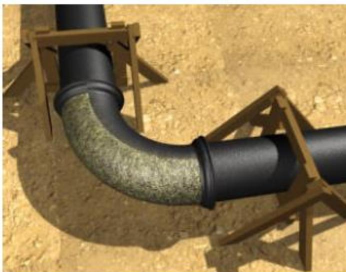
Posicionado e assentado o tubo, conexão ou aparelho, será feito seu escoramento, visando garantir sua imobilidade quando da execução do bloco.
